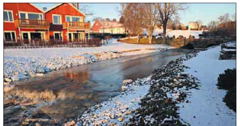
TERSKLER: Det er anlagt terskler i utløpet av Granelva.
